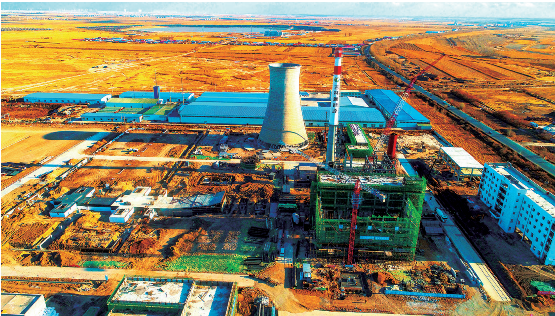
洮南市注重环境改善,引进新能源电厂落户洮南。图为正在建设中的吉林新能源电厂。
