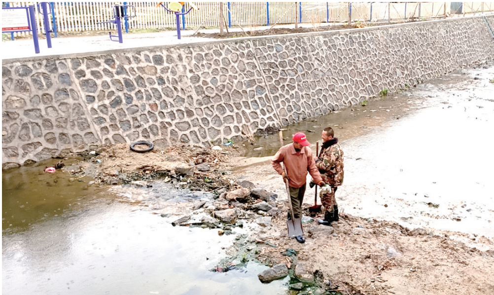
靖宇县赤松镇赤松村河道保洁员对村内河床进行平整、清理，为防汛安全做好基础保障。
