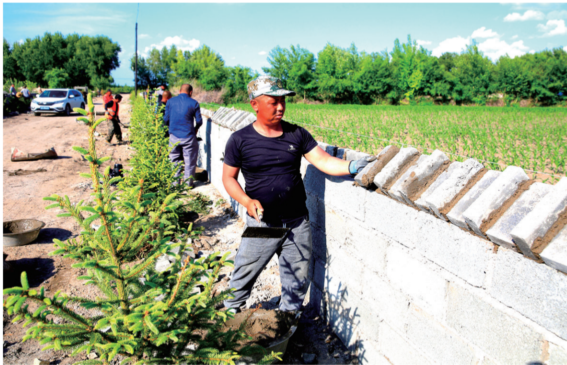
洮南市蛟流河乡龙山村“千村示范”乡村振兴建设全面施工中,图为建设施工现场。 邱会宁 范海辉/摄
