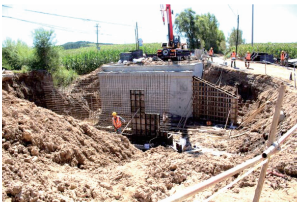
危桥改造施工现场
