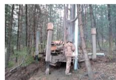
重新为管护队打一眼深水井。4月27日,经过科学选址,林场组织专业人员在管护房的南侧成功打出一眼69米的深水井,经洗井、淘井等工序,抽出的水清冽甘甜,专业检测后符合饮用水标准,彻底解决了管护队的用水难题。(吕兰)
