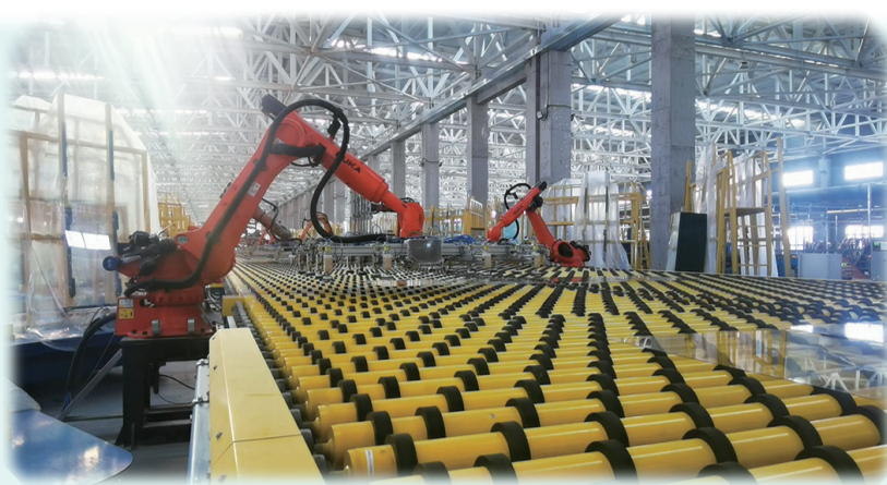
吉林迎新玻璃有限公司“一窑三线”项目生产调试现场
