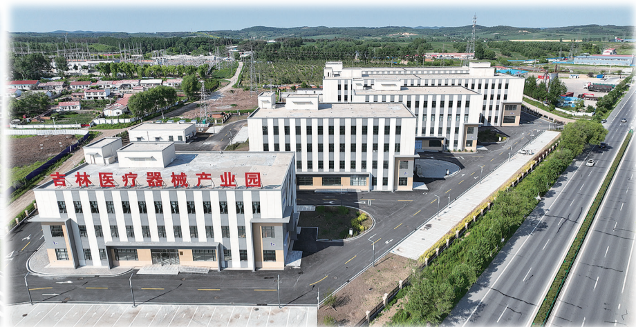
快速崛起的吉林医疗器械产业园
